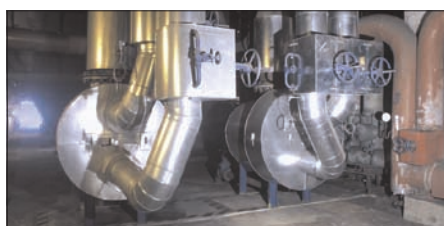
Instalace výměníků jako parních ohříváků typ PSHE 9 rozebiratelné provedení o výkonu 2 x 16 MW na Sokolovská uhelná, a.s., závod Vřesová
