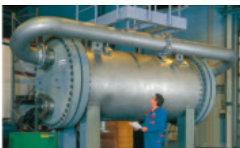
30 МВт экономайзер сточных вод на этиленоксидном заводе, тип PSHE 14HH-968/2/2
